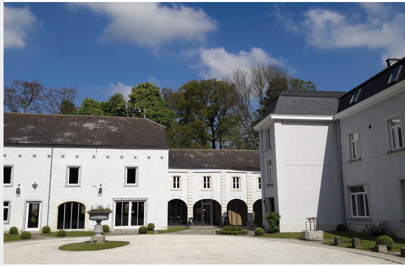
© Château de l'Ardoisière
