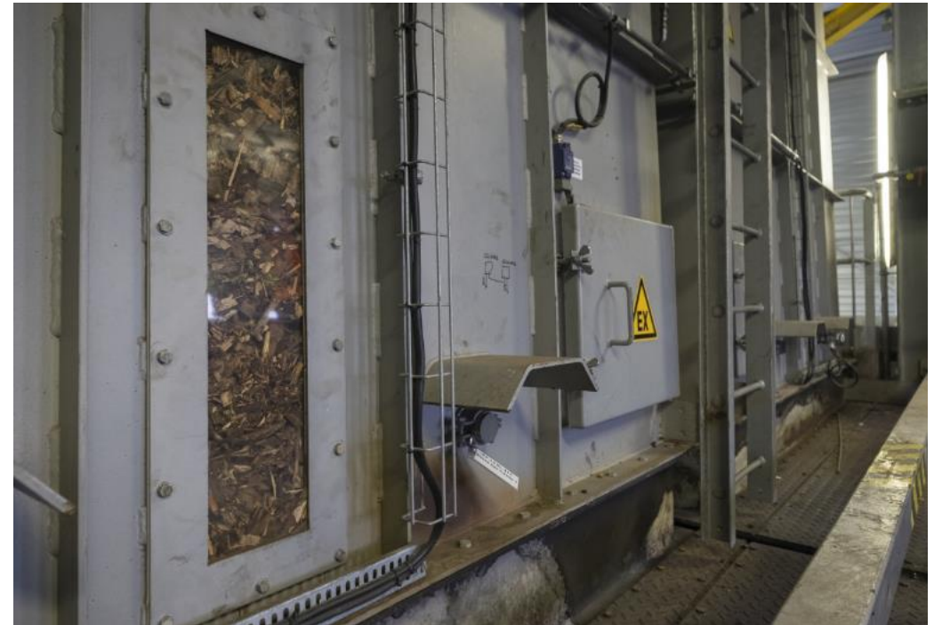
Arrivée des plaquettes dans une chaudière à bois
