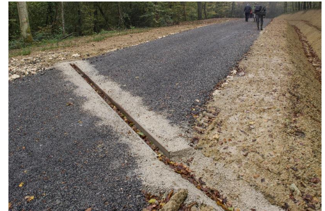
Revers d'eau pour évacuation à curer régulièrement
