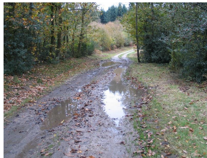
Stagnation eau sur route forestière
